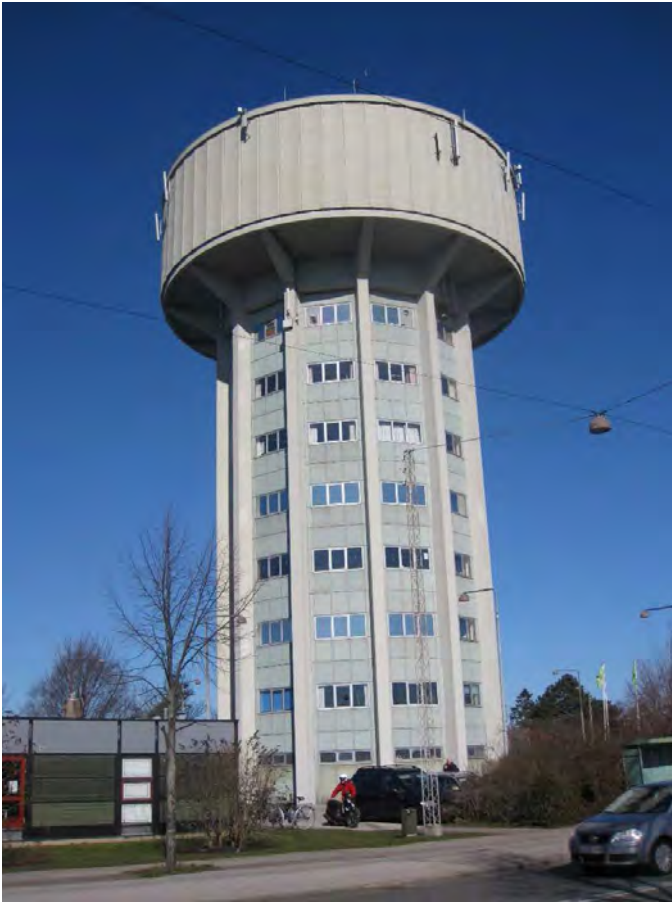
Vandtårnet på Oliefabriksvej.
