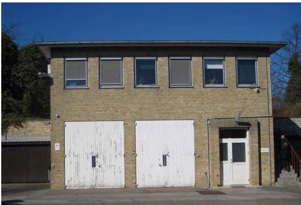
TÅRNBYFORSYNING Vand A/S vandværk
