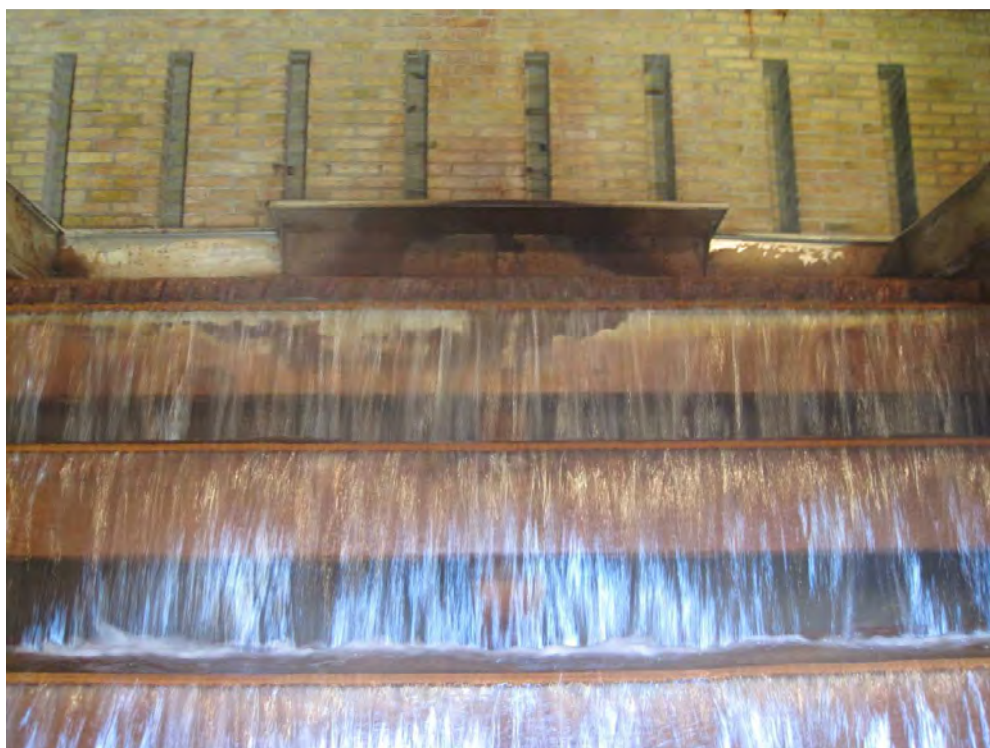
Iltningstrappen på Tårnby Vandværk.
