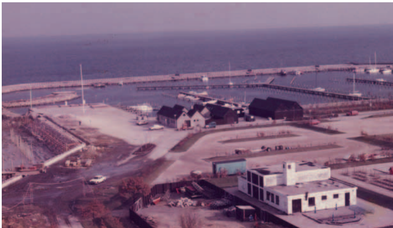
Kastrup Marina under opførelse. Fotograferet fra brandvæsenets 30 meter høje stige i efteråret 1986. Foto: Stads- og Lokalarkivet, B1475
